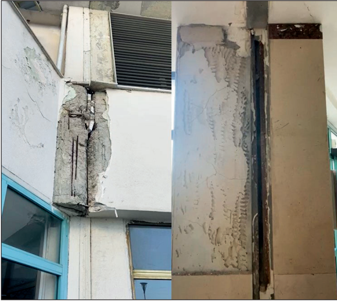
Şekil 1: 6 Şubat depreminde zarar gören ve tahliye edilen Çukurova Üniversitesi Tıp Fakültesi Balcalı Hastanesinin zarar görmüş kolonlarının görüntüsü.
