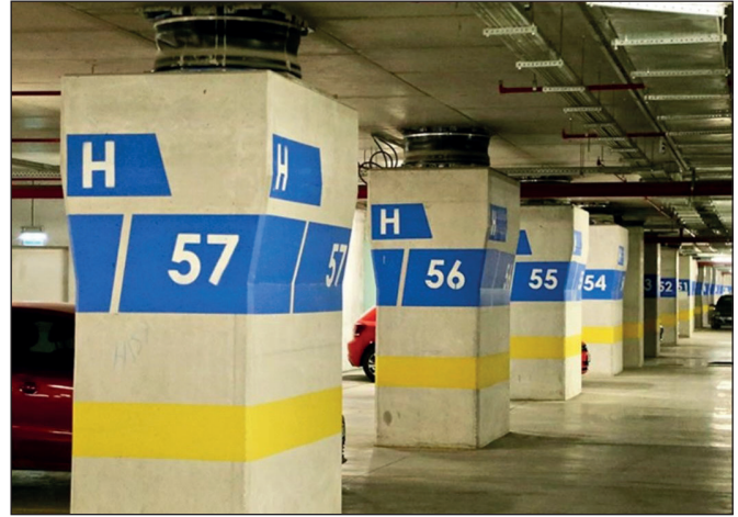
Şekil 3: Sismik izolatör uygulaması.
